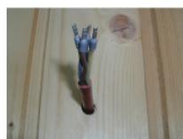
1. Термостойкий сигнальный кабель для датчика провести через предусмотренный проход линии и через отверстие в плите для крепления.
